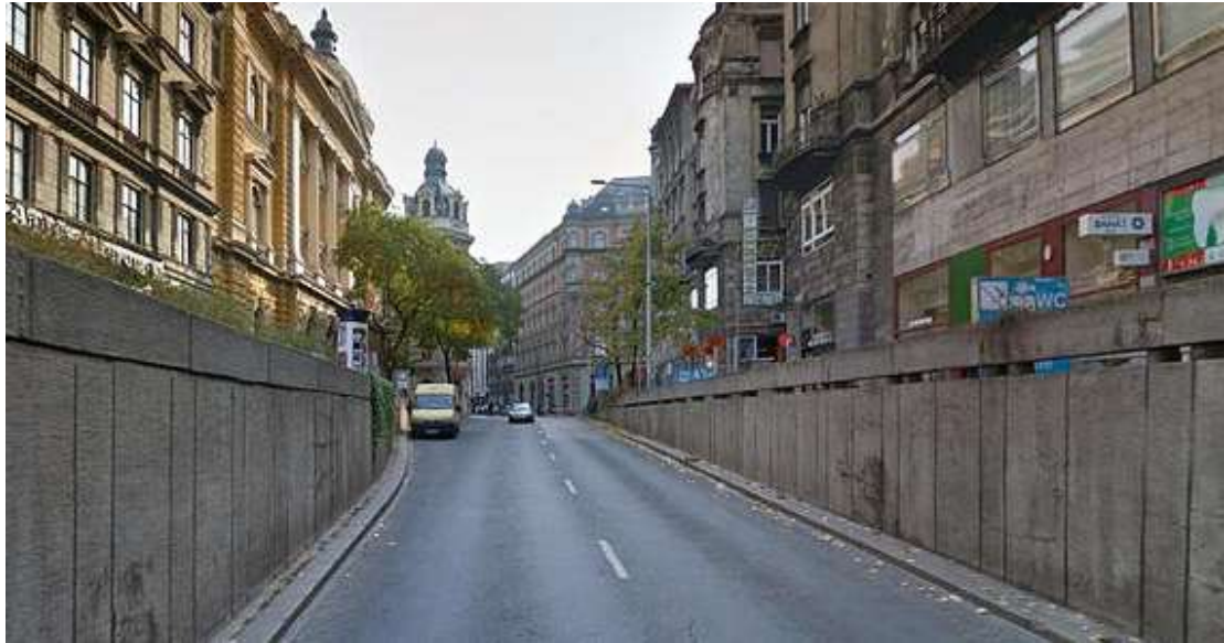
Φωτογραφία 2: Βουδαπέστη, ανισόπεδη σήραγγα στο κέντρο της πόλης δημιουργεί αποκοπή στα πολεοδομικά τετράγωνα
