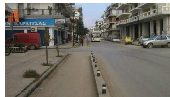
Εικόνα 4.9.11.β. Αμφίδρομος διάδρομος κίνησης ποδηλάτου στην Καρδίτσα. Ο φυσικός σχεδιασμός διαχωρίζει την κίνηση του ποδηλάτου από τον διάδρομο κίνησης των μηχανοκίνητων μέσων
