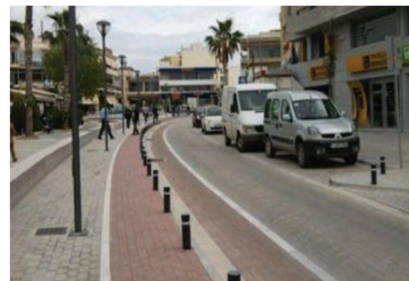
Εικόνα 4.9.11.α. Ποδηλατόδρομος στην κεντρική πλατεία του Μαρκόπουλου Αττικής. Υποχρεωτική αντίρροπη λωρίδα. Η ομόρροπη κίνηση γίνεται σε υποχρεωτική λωρίδα επί του οδοστρώματος
